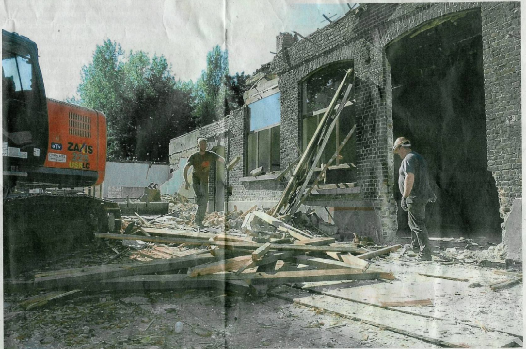
De afbraakwerken aan de basisschool zijn begonnen. Foto JVK
